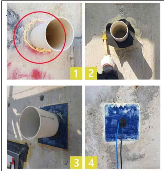
[그림 부록-15] 배관/전선용 기밀자재의 콘크리트조 시공 방법
