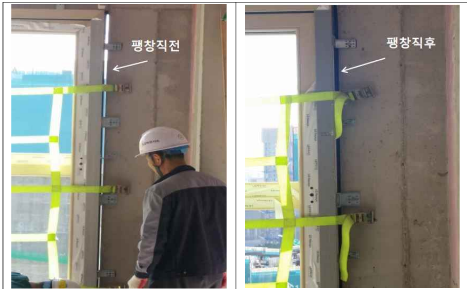
[그림 부록-5] 팽창테이프 시공 후 모습
