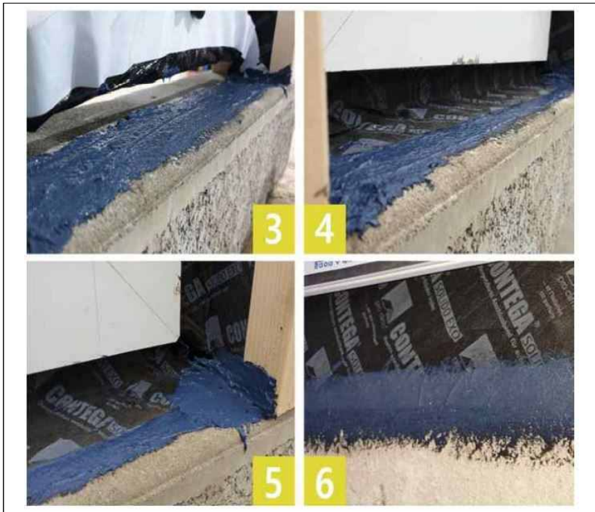
[그림 부록-13] 기밀테이프 선시공 후 탄성도막제 창호시공방법
