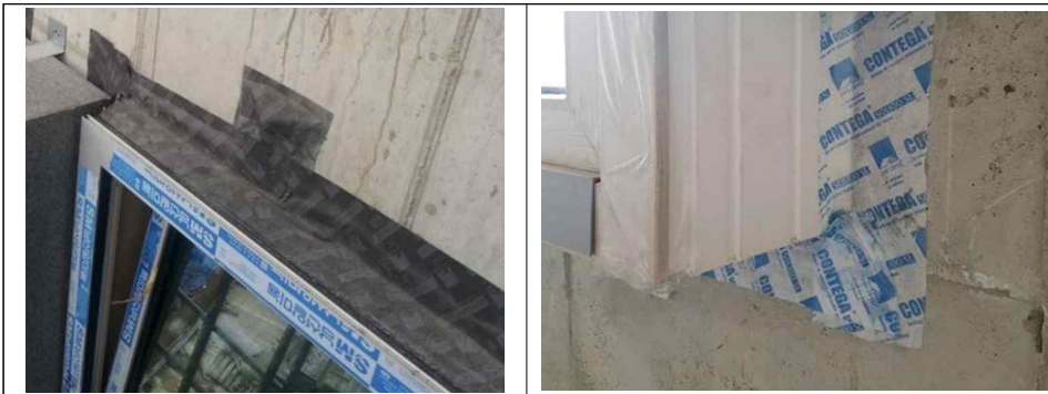
[그림 부록-11] 돌출부 시공 모습
