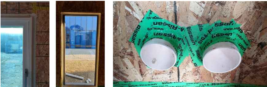
[그림 5-4] 기밀시공 완료 후 모습
