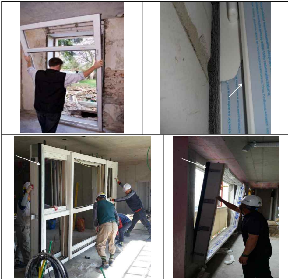
[그림 부록-4] 팽창테이프 설치
