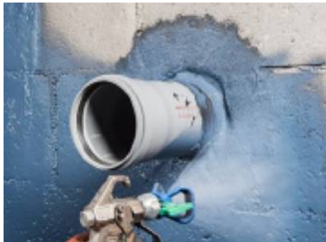
[그림 4-12] 탄성도막 방습제 에어리스 시공
