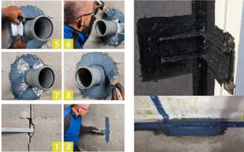
[그림 4-11] 탄성도막 방습제 시공
