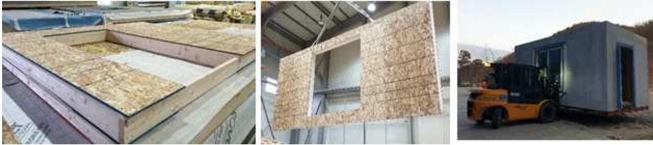
[그림 5-2] 구조체(패널라이징) 제작 및 현장설치 모습
