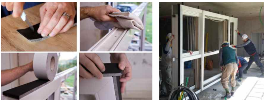
[그림 4-7] 팽창테이프 시공
