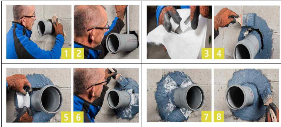
[그림 부록-14] 탄성도막제 배관 및 벽체부 시공방법
